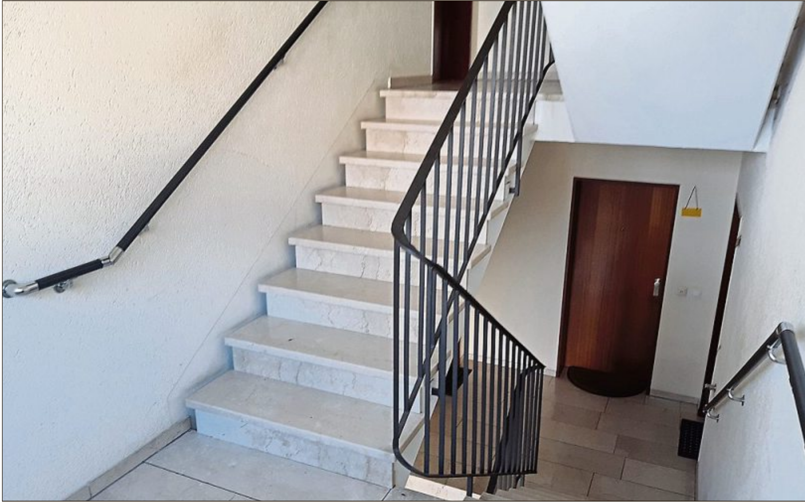
Mit Treppenhandlauf nachgerüstete Eigentumswohnanlage.
