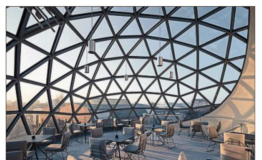
Die Bogentreppe mit Glasgeländer. Die schwebende Glaskugel auf dem Bestandsgebäude und in der Glaskugel. FOTOS: MARGRET HOPPE, SEBASTIAN STUMPF
